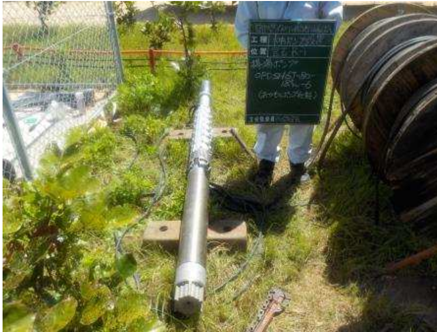
水中モーターポンプ設置
