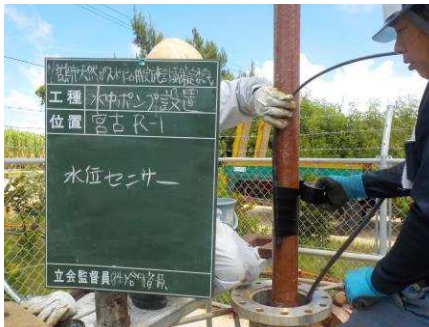
水位センサー設置
